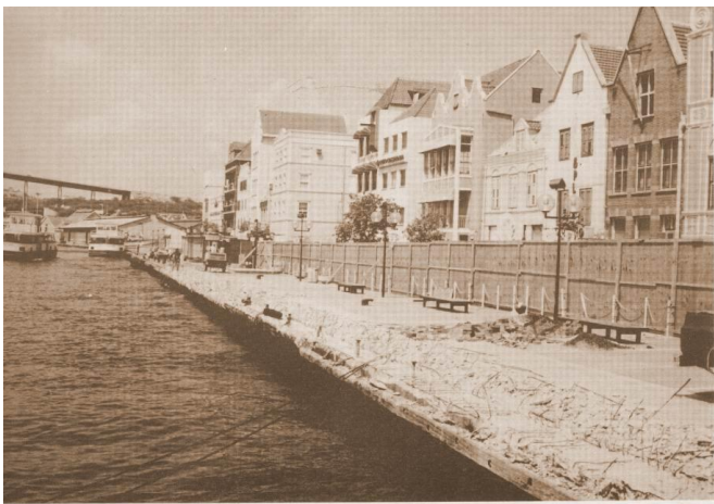
Voor de herstelwerkzaamheden moest in 1993 de kade voor het publiek worden afgesloten met houten schuttingen
